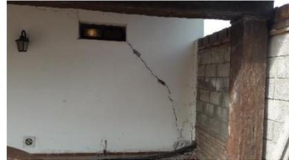
Generalmente, se produce una alta aparición de grietas en muros debido a asentamientos de las construcciones, por los siguientes motivos: suelos deformables, alteraciones de las propiedades del mismo como consecuencia de un aporte excesivo de agua (ascenso de napas freáticas o ingreso de aguas ya sea por lluvia o cañerías defectuosas), alteración de los suelos colindantes (por construcciones), entre otros motivos.
