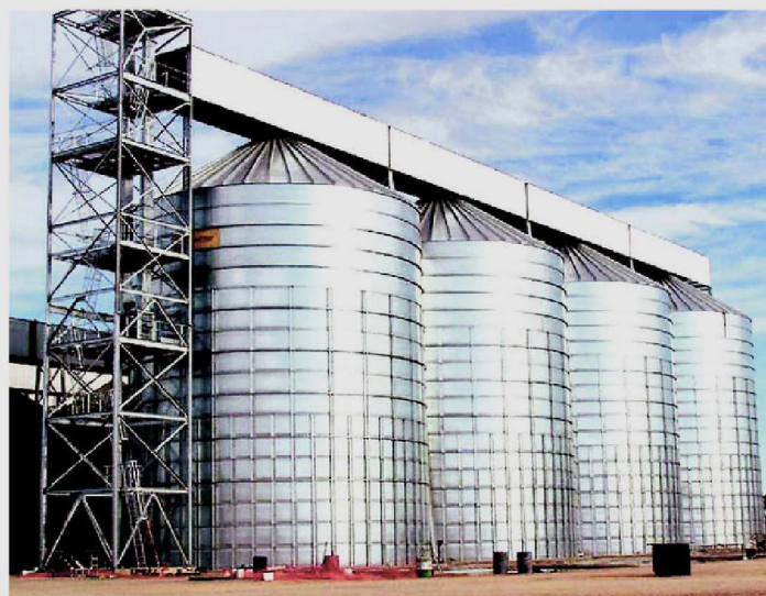
Silos para acopio.
